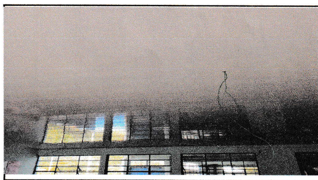
Foto 4: VISTA PREVIO, AREA A INTERVENIR.
