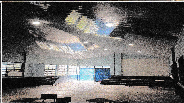
Foto 2: VISTA PREVIO, AREA A INTERVENIR.
