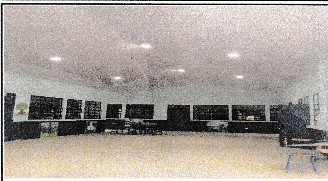
Foto 1: VISTA PREVIO, AREA A INTERVENIR.
