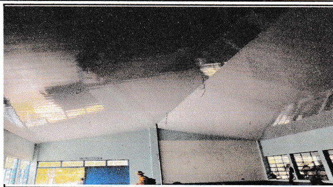
Foto 2: VISTA PREVIO, AREA A INTERVENIR.
