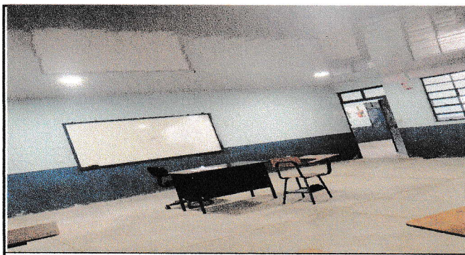
Foto 5: VISTA PREVIO, AREA A INTERVENIR..
