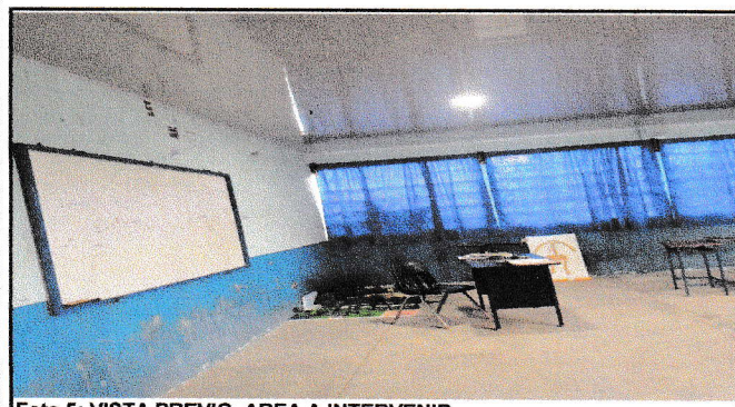
Foto 5: VISTA PREVIO, AREA A INTERVENIR..
