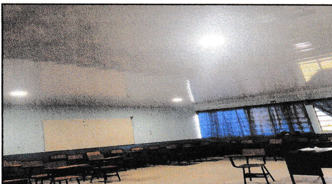
Foto 3: VISTA PREVIO, AREA A INTERVENIR.
