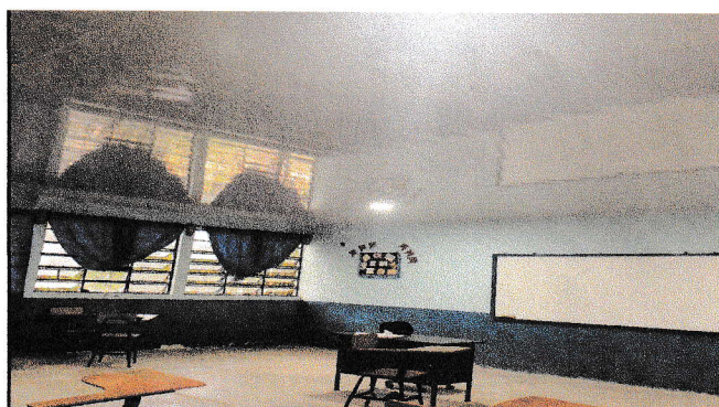
Foto 4: VISTA PREVIO, AREA A INTERVENIR.
