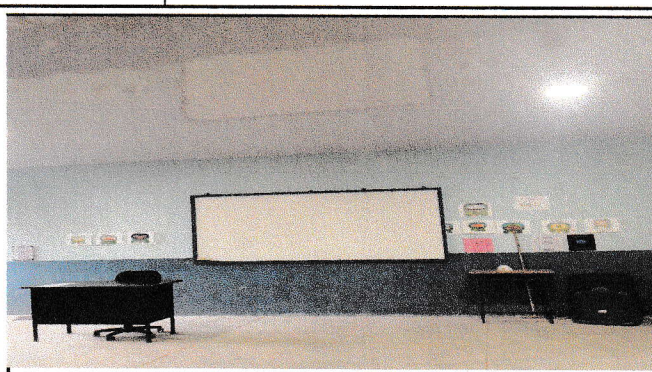
Foto 2: VISTA PREVIO, AREA A INTERVENIR.
