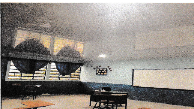
Foto 4: VISTA PREVIO, AREA A INTERVENIR.
